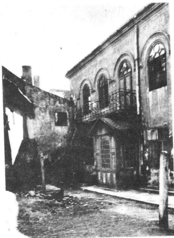
Fragment elewacji południowej z przedsionkiem dobudowanym w 1929 r., fot. z okresu międzywojennego
